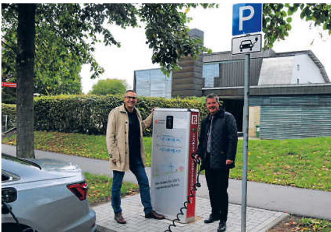
Stadtwerke-Geschäftsführer Gebhard Gentner (l.) und OB Thilo Michler bei der Inbetriebnahme der neuen Ladesäule an der KULTURA Foto: Stadtwerke Öhringen
