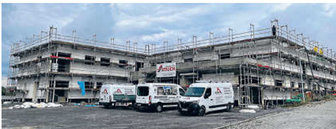
Neubau Kindergarten Friedenshort
