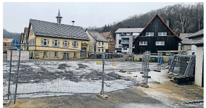
Die Heinzmannscheune in der Heuholzstraße 2 in Ohrnberg wurde abgerissen Foto: Stadt Öhringen
