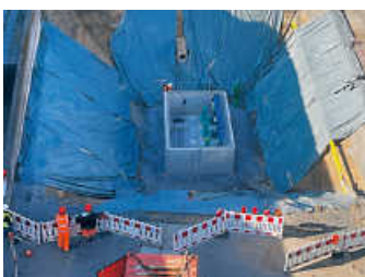
Einbau vom Havarieschacht
